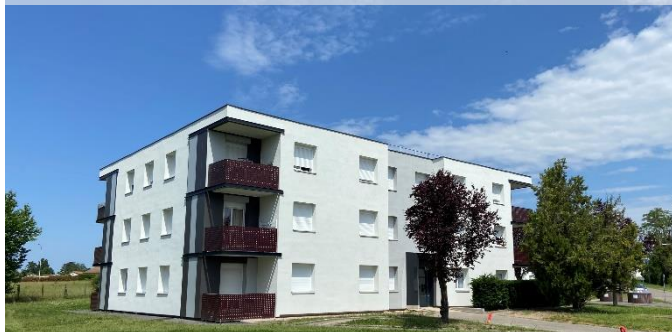
RÉHABILITATION LOGEMENTS LEZOUX
