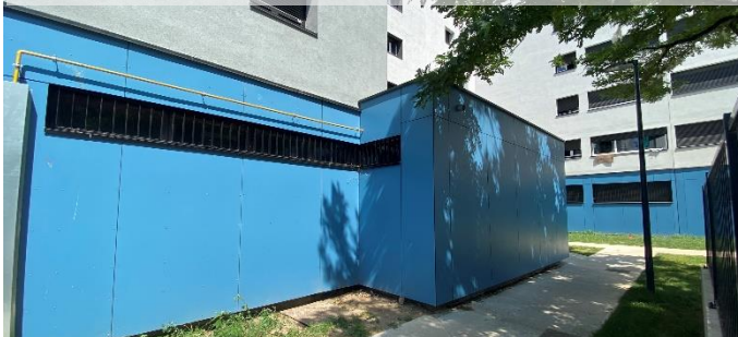
REHABILITATION RÉSIDENCE PHOENIX ET LOUISIANE
