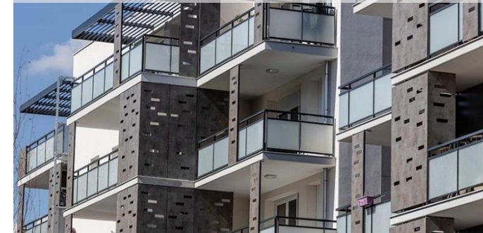
BALCONS DU SQUARE DE SAINT EGRÈVE
